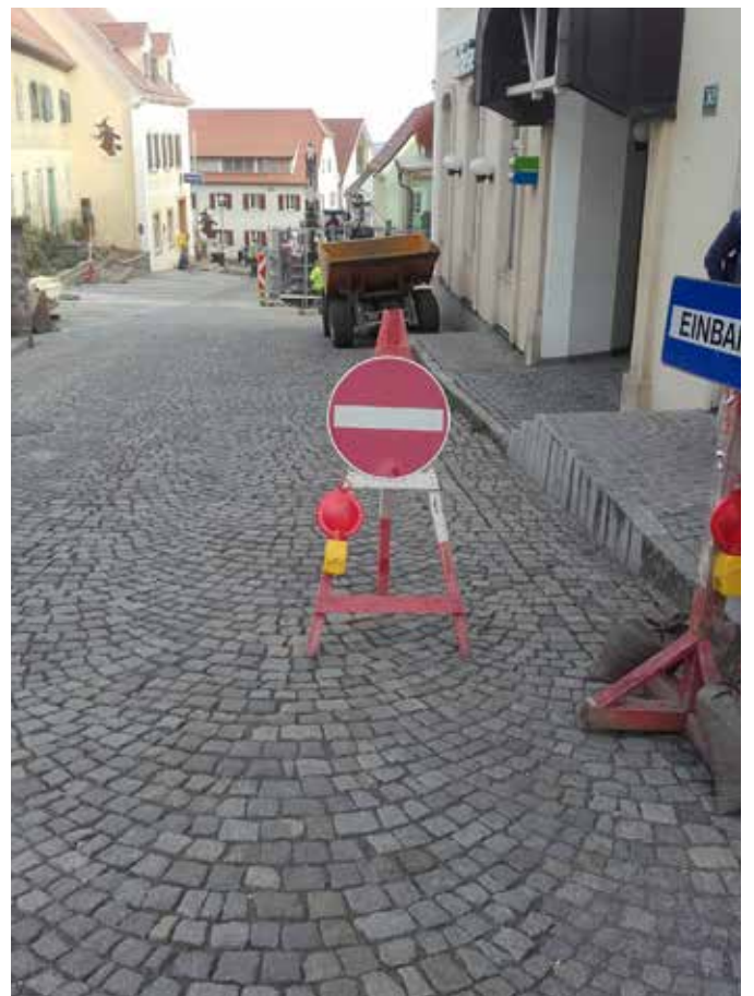
Grabungsarbeiten im Ortsbereich - Strom, Fernwärme und Mitverlegung der Wasserleitung
