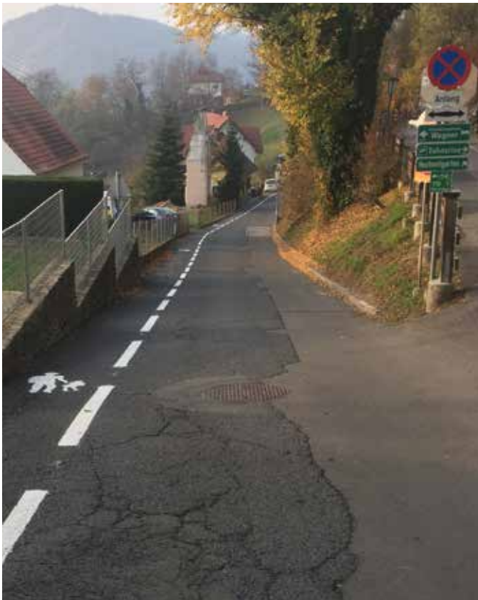
Der Altenmarktweg mit neuem Gehstreifen.
